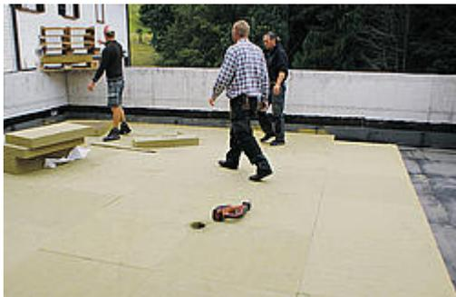
Pannello isolante resistente al calpestio per l'uso in tetti piani, previsti per essere utilizzati da persone e/o per installazioni. Come isolamento centrale nell'intercapedine di muri prefabbricati a doppia lastra in calcestruzzo.
