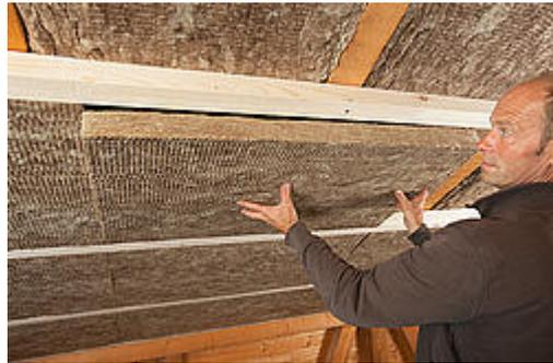
Kompakte Dämmplatte für den universellen Einsatz im Innenausbau und Aussenbereich. Zusatzdämmung in Wänden, Dächern, Böden sowie Holztreppwänden. Diverse Anwendungen im Akustikbereich.
